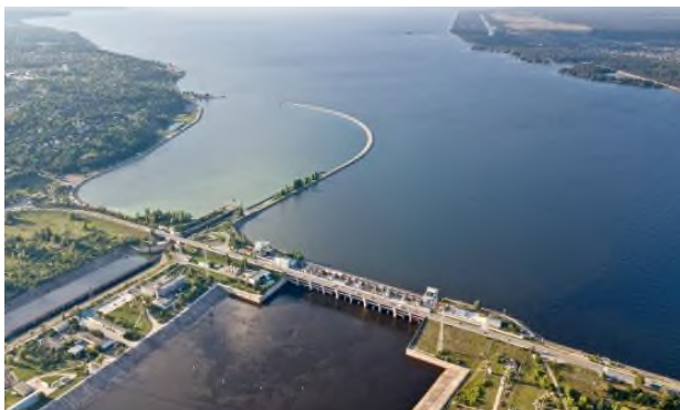
Комплекс гідротехнічних споруд Київського водосховища
