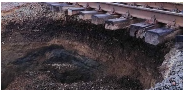
Карстове провалля під залізницею (Чернівецька область)
