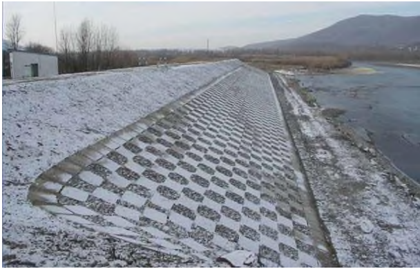
Водозахисна дамба с. Крива від паводкових вод р. Тиса
